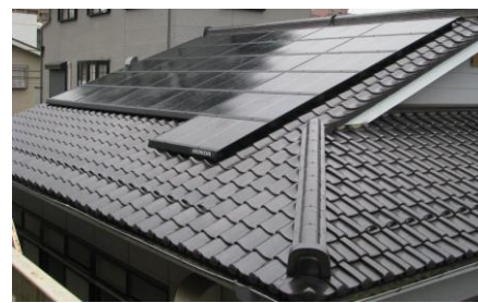
2号機新狭山1,3丁目自治会館
